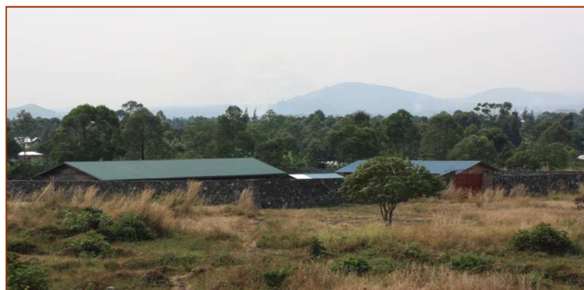
Vue d'ensemble du Centre d'Hébergement
